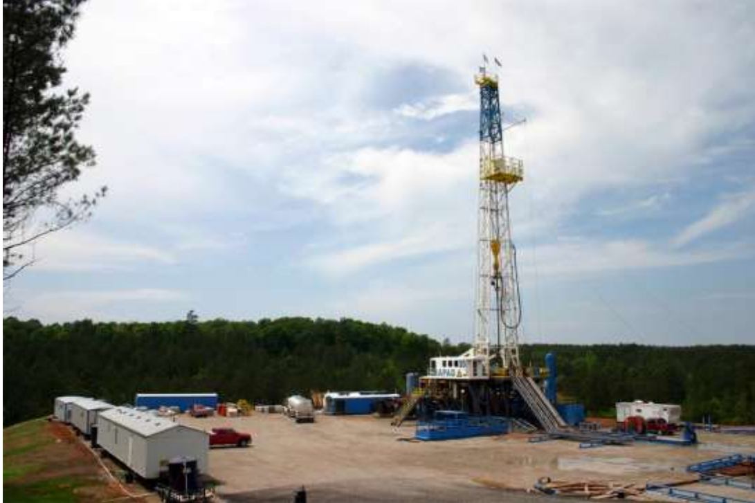
ภาพ : แท่นขุดเจาะบนบก (เครดิตภาพ RAPAD)
